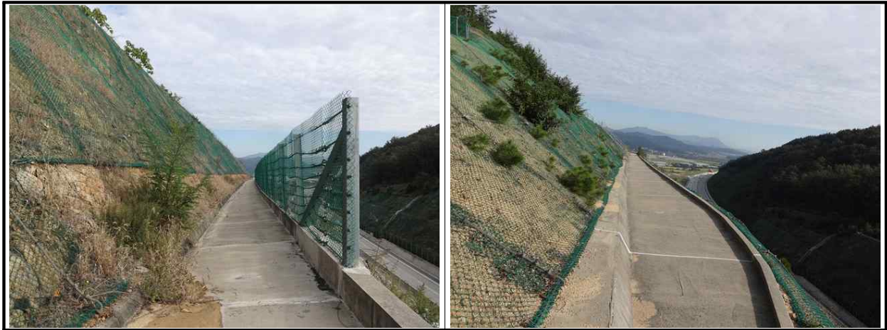
【그림 5.3.3】 배수시설 전경
